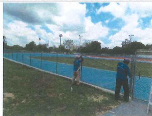
Reparación de la malla del área de patinaje
