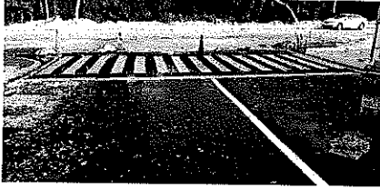
Pavimentación de carpeta asfáltica en la calle lirios entre calle ceiba y calle Caoba
