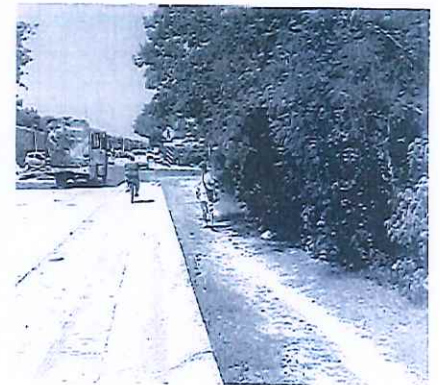
Reporte Fotografico Av. Kantenah / Av.115
