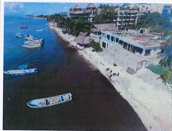
Figura 8. Vista de la calle 14 a 12.
