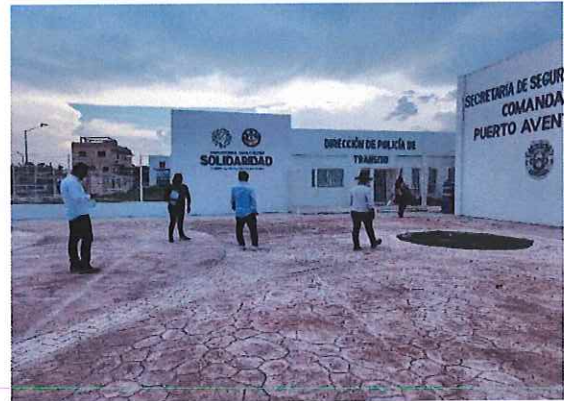
CONSTRUCCIÓN DE SUBCOMANDANCIA EN VILLAS DEL SOL. SEGUNDA ETAPA.
