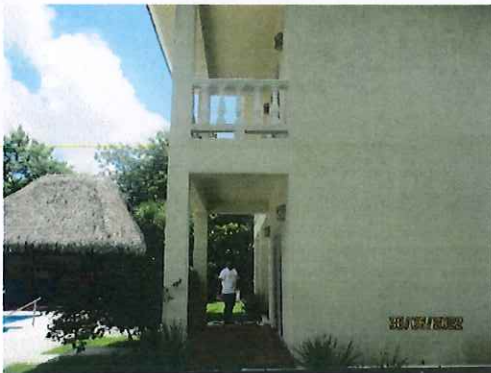
Realización de Inspecciones físicas a predios
