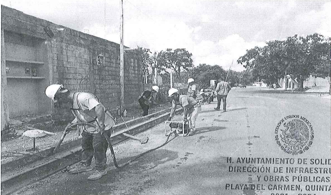
CALLE 34 NORTE POR AVENIDA 135
