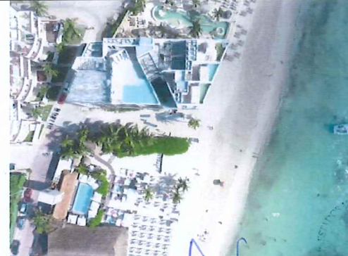
Figura 6. Vista del acceso de la calle pelicanos.
