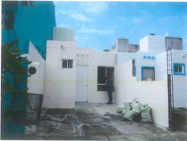
Realización de Inspecciones Físicas
