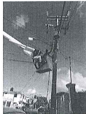
11.3 atención y modernización a luminarias
