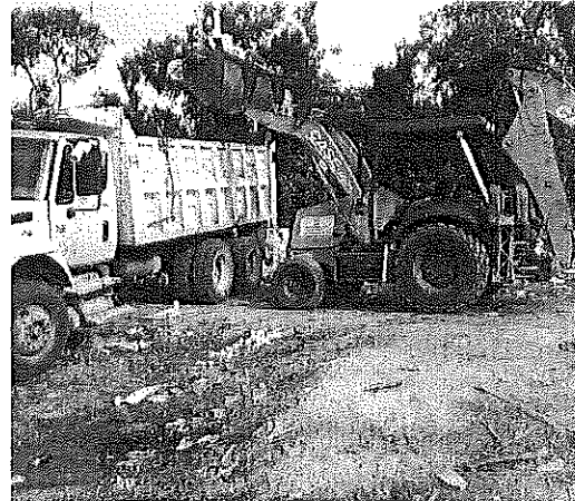
Ilustración 1.- Adecuación de áreas a desnivel en Frac. Villamar II
